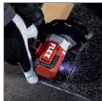
... vrubování dlaždic a přímé odsávání vzniklého prachu...
